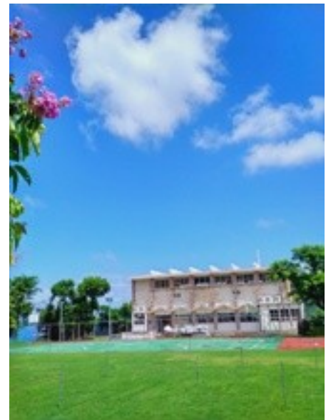
海光教堂正在進行裝修
