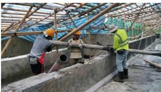
香港三育書院行政大樓屋頂防水
