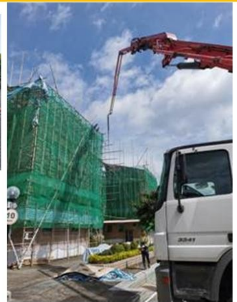
香港三育書院行政大樓屋頂防水和維修項目
