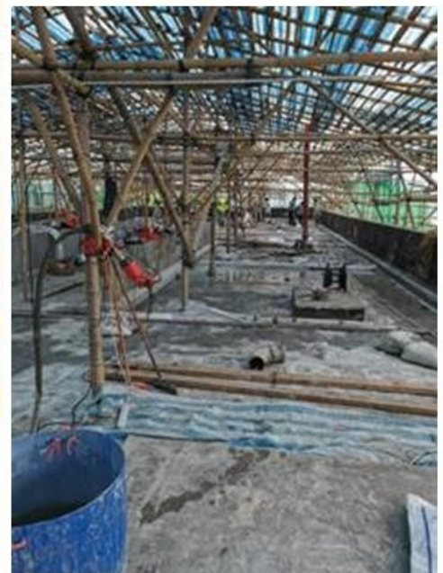
香港三育書院行政大樓屋頂防水
