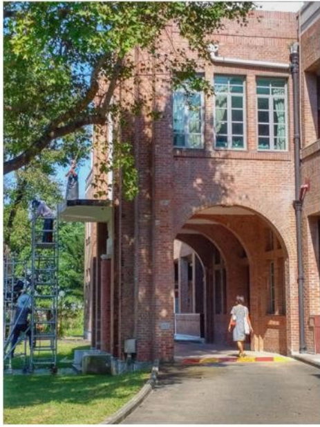
工人正在修理行政大樓的拱門。
