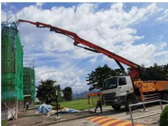
香港三育書院行政大樓屋頂防水和維修
