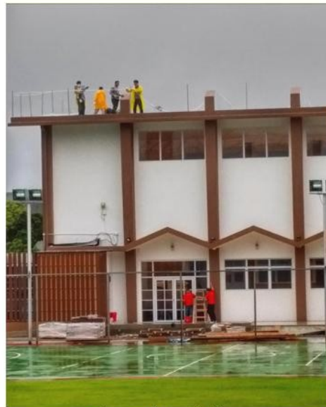
景輝堂的屋維修。
