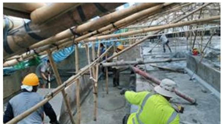
香港三育書院行政大樓屋頂防水
