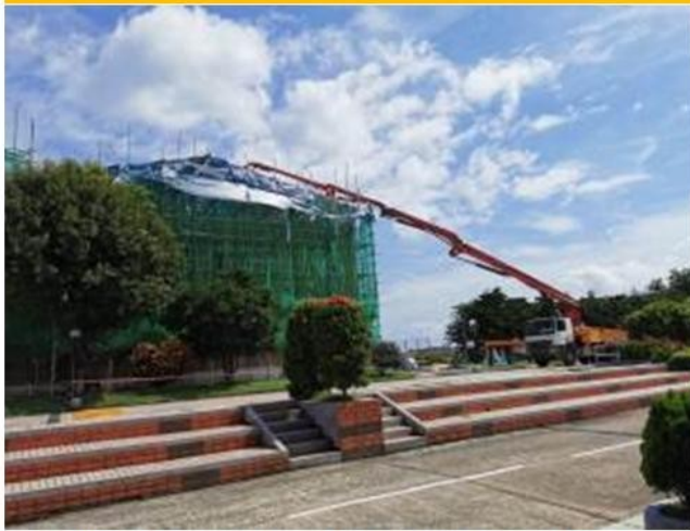
香港三育書院行政大樓屋頂防水和維修項目
